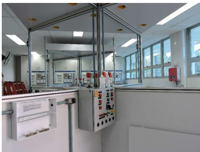
Figura 6: Oficina de Instalações Prediais
